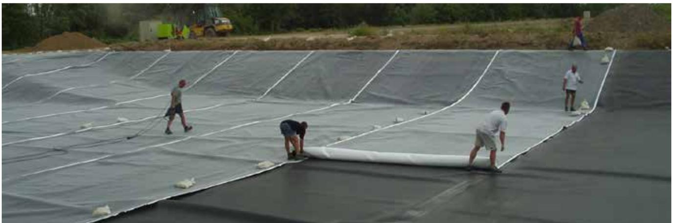
Las membranas de PEHD impermeabilizan los filtros de suelo centrales que absorben el agua de lluvia de las superficies de tránsito aéreo contaminada por el deshielo de la superficie.
