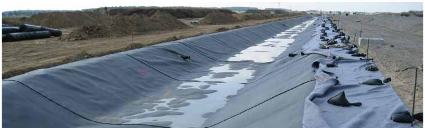
Asimismo, las membranas de impermeabilización de PEHD permiten instalar filtros de suelo no centrales junto a las pistas de despegue, aterrizaje y rodaje. Estos filtros preparan el agua de lluvia que contiene las impurezas generadas por el tránsito aéreo y el deshielo de la superficie antes de conducirla hasta los filtros de suelo centrales.
